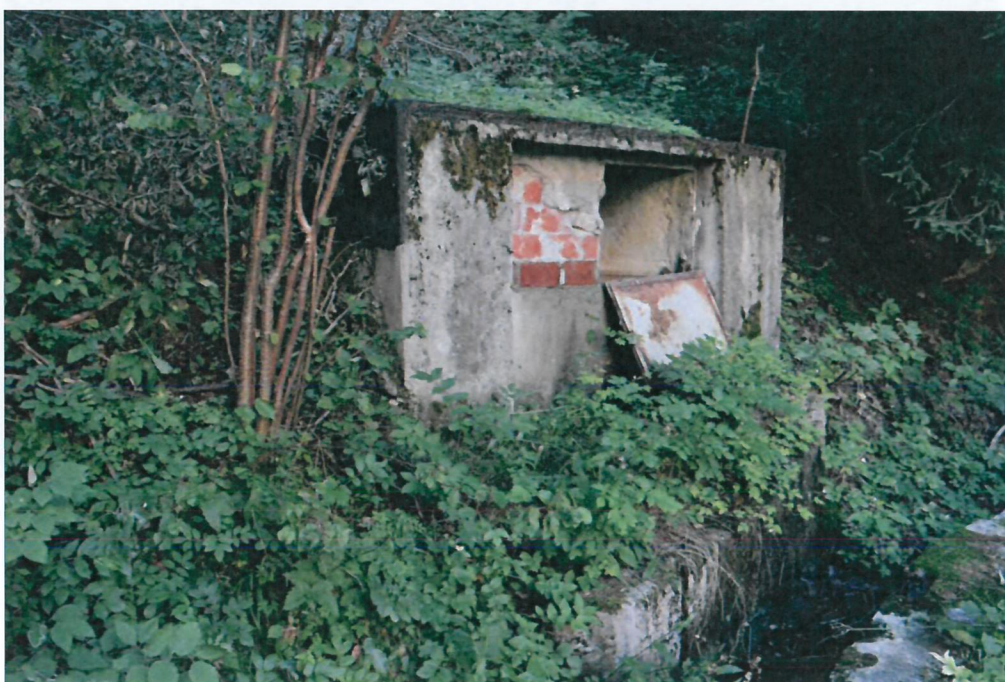
Figura 4: Il torrino posto sul percorso dell'acquedotto
