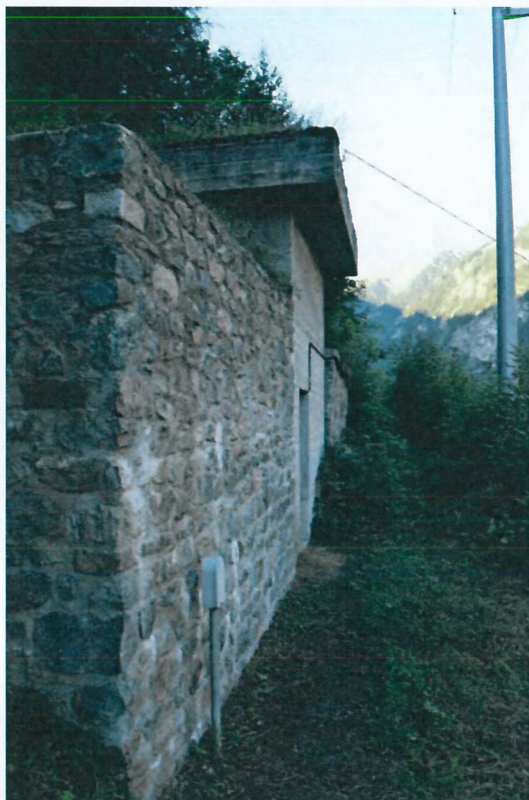
Figura 3: La vasca dell'acquedotto ad inizio tracciato
